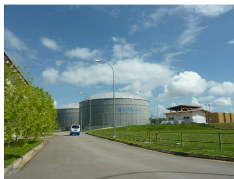
Newater 製造プラント
