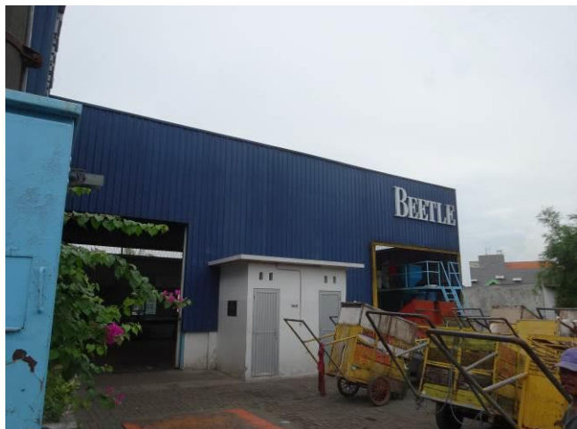
西原商事 スラバヤ中間処理施設外観
