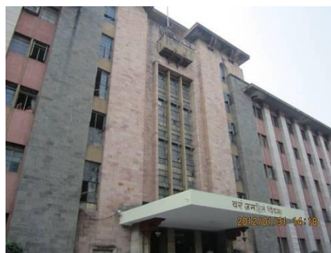
プネー市役所の外観。
