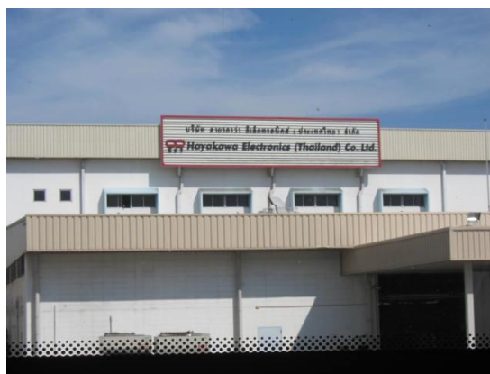
ハヤカワ電線工業タイの外観
