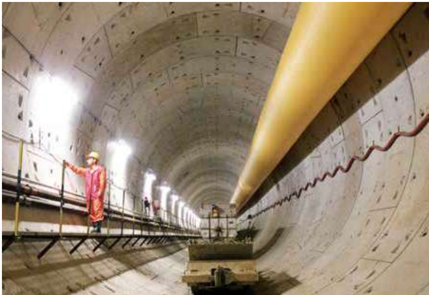
大深度トンネル
