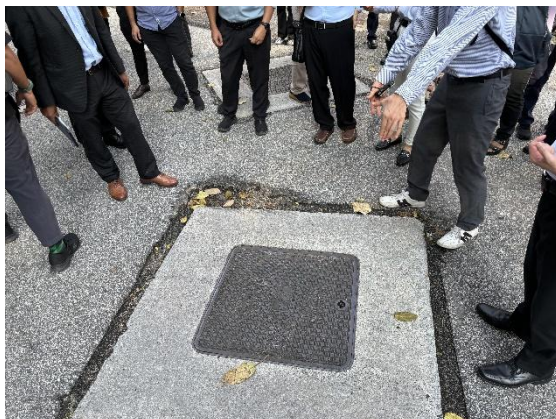
現地視察① 舗装の施工に関する指導
