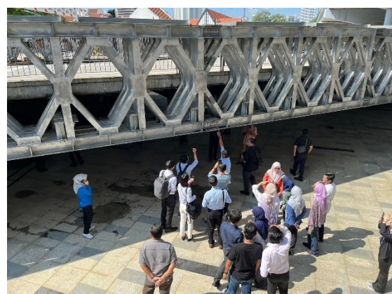
現地視察② 橋梁点検に関する指導
