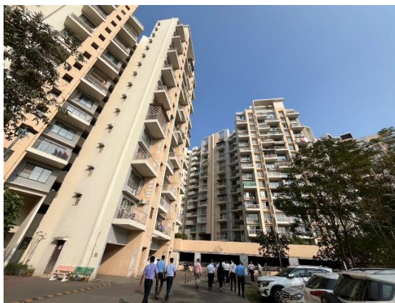
現場視察②高層マンション
