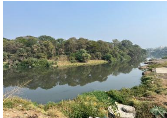
現場視察②定点カメラ設置の予定（下流）
