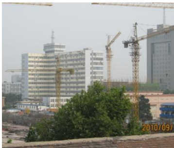
市中央部の再開発工事
