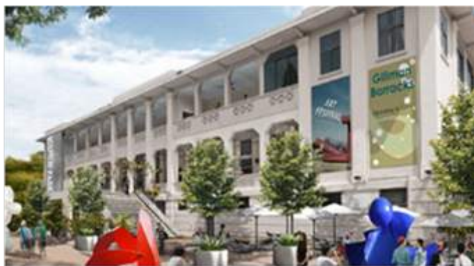
(図 3-13-12) ギルマンバラックス外観 1112
