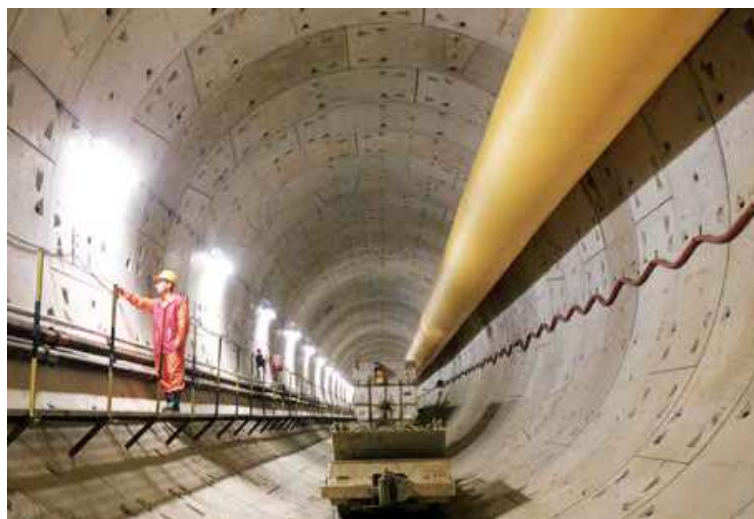
大深度トンネル
