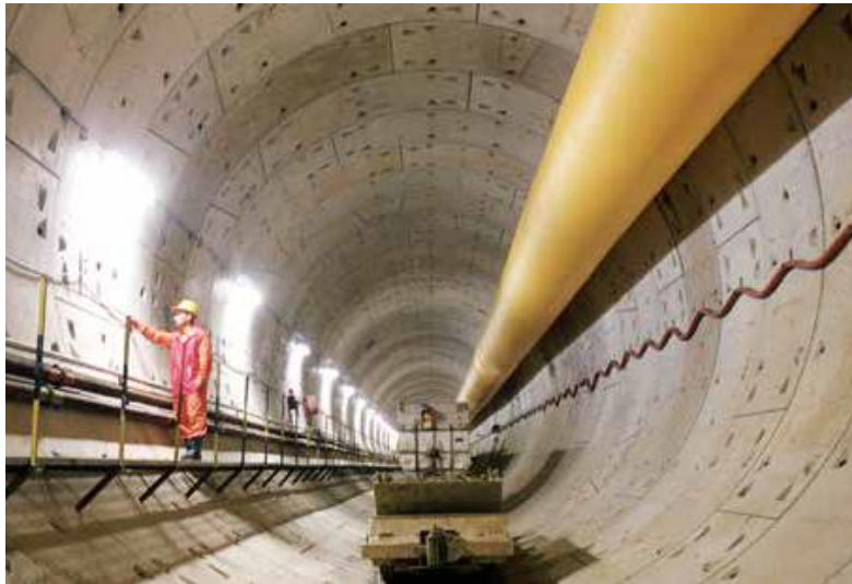
大深度トンネル
