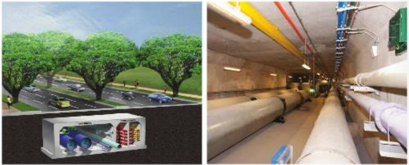
【水道管（NEWater、飲料水など）、通信ケーブル、電気ケーブルなどが効率的に配置されたことを示す断面図及び写真】
