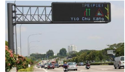
高速道路監視システム
