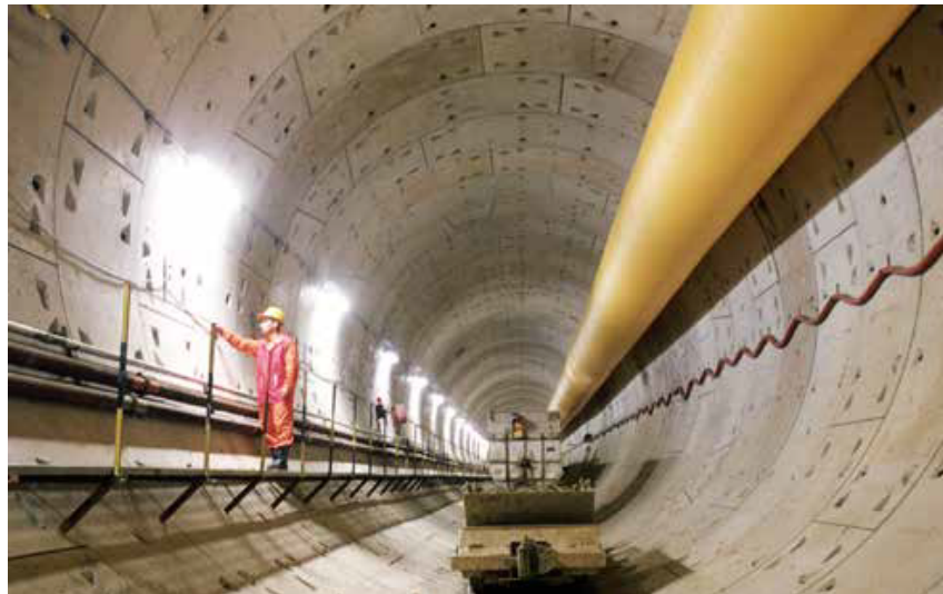
大深度トンネル
