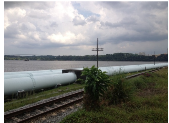
ジョホール海峡に設置されている 送水管
