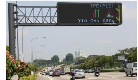
高速道路監視システム
