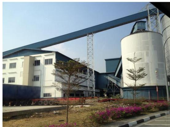
砂糖のサイロ：上部のコンベアを通過して船から直接運ばれます。
