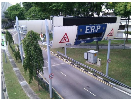
ERP ガントリー（跨線橋）
